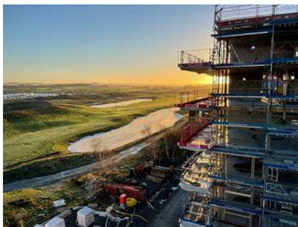
Torslanda Terrasser är slutsålt och byggnation av projektets samtliga tre huskroppar pågår enligt plan.
